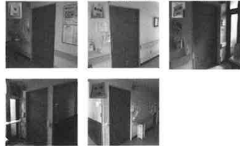
改修後: 501~506 療養室扉及びサイン
