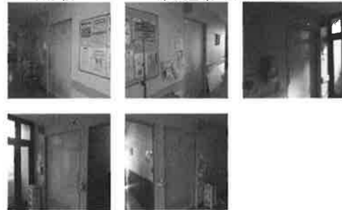
改修前: 501~506 療養室扉及びサイン
